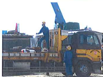
ヤードでの作業中
