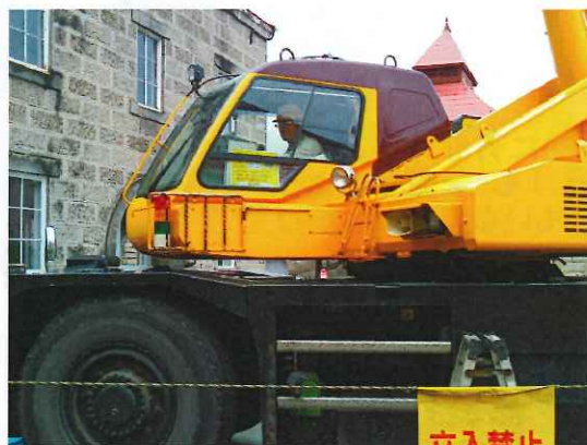
【25 t ラフター山崎オペレーター】
