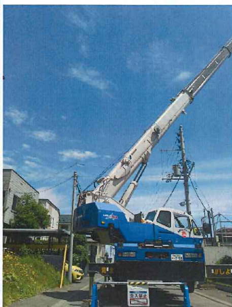
【25 t ラフター大島オペレーター】
