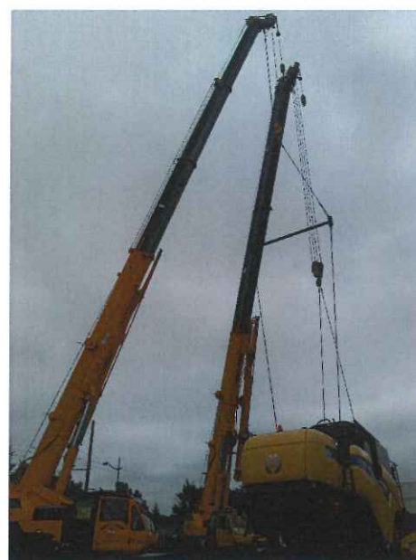
【25 t ラフター 斉藤公オペレーター】 & 【60 t ラフター 山本剛オペレーター】
