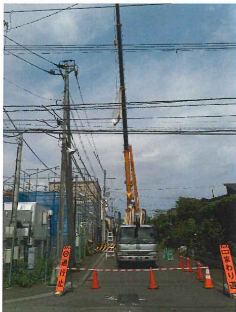
【25 t ラフター伊藤オペレーター】
