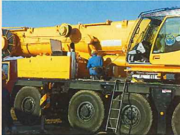
130tクレーン配線中 岩村オペレーター
