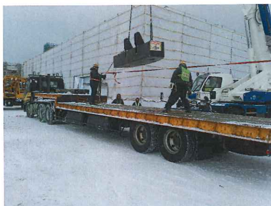
【90 t クローラークレーン解体作業】
