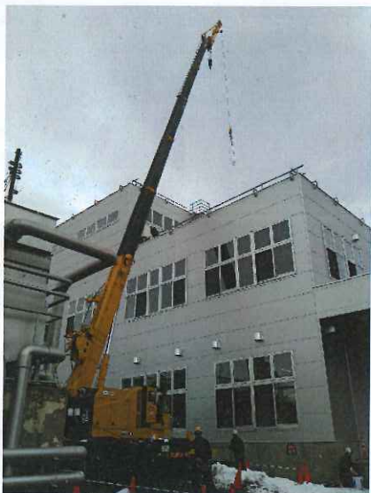
【25 t ラフター 府中オペレーター】
