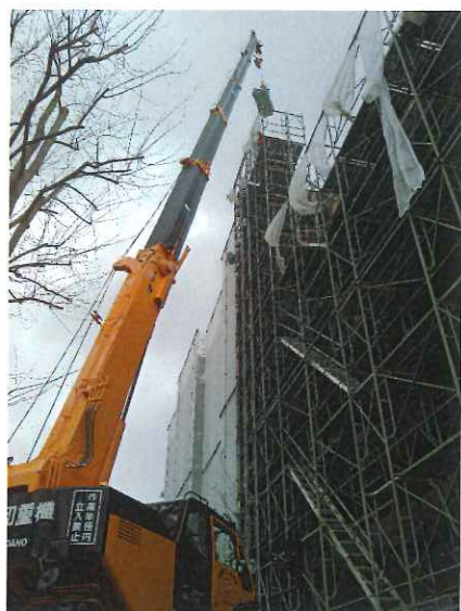
【25 t ラフター 三橋オペレーター】
