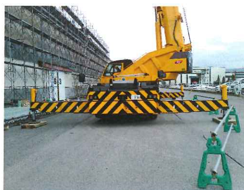
【70 t ラフター 伊藤オペレーター】
