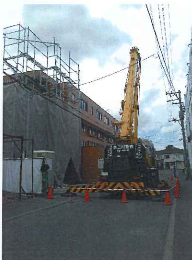
【25 t ラフター 伊藤オペレーター】
