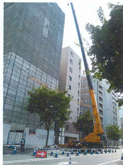
【70 t ラフター 小野寺オペレーター】
