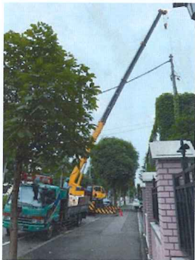
【25 t ラフター 谷口オペレーター】
