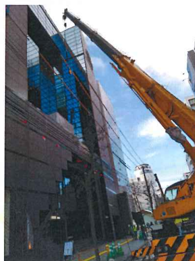
【25 t ラフター 伊藤オペレーター】
