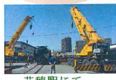
苗穂駅にて 合吊りで積込む様子
