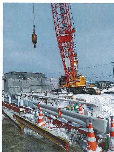
【120 t クローラー 梶原オペレーター】
