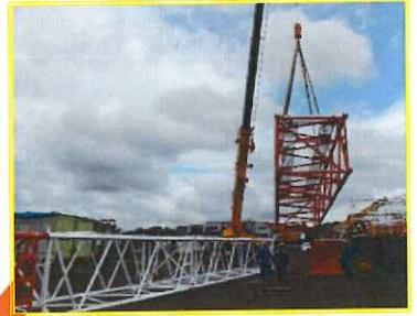
クレーンを組み立てる為に、部材を別のクレーンで吊っています! 入社してから何度か組み立て作業を見ておりますがクレーンでクレーンを吊るといふ光景は何度見ても迫力があり、ワクワクします(≧▽≦)
